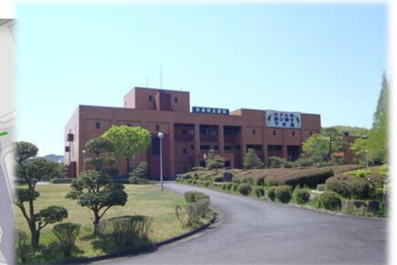
土岐市浄化センター (写真は緑の矢印周辺からの外観です)
